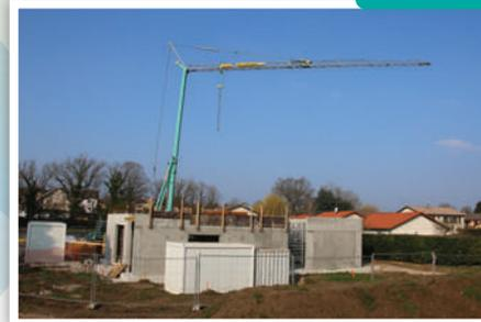
Les travaux de la micro-crèche engagés par la Communauté de Communes Centre Dombes se poursuivent ; le gros-œuvre (murs et couverture en béton) est bientôt achevé. La circulation des piétons autour du chantier a été maintenue de façon à créer le moins de gêne possible. Le parking a été préservé. Le chantier étant conduit dans le respect du planning, l'ouverture se fera comme prévu début septembre 2016.
